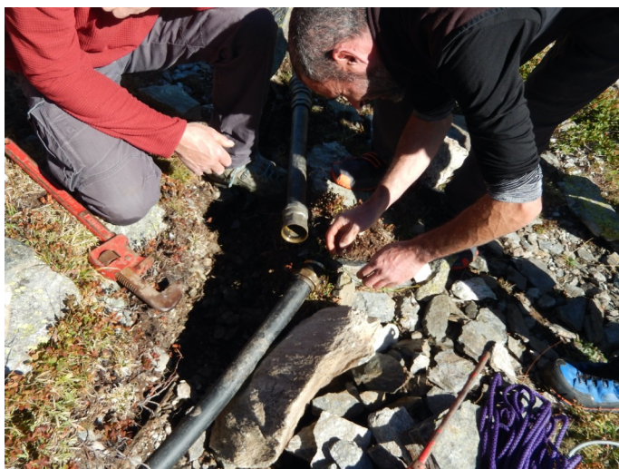
Raccordement des tuyaux d'alimentation d'eau
